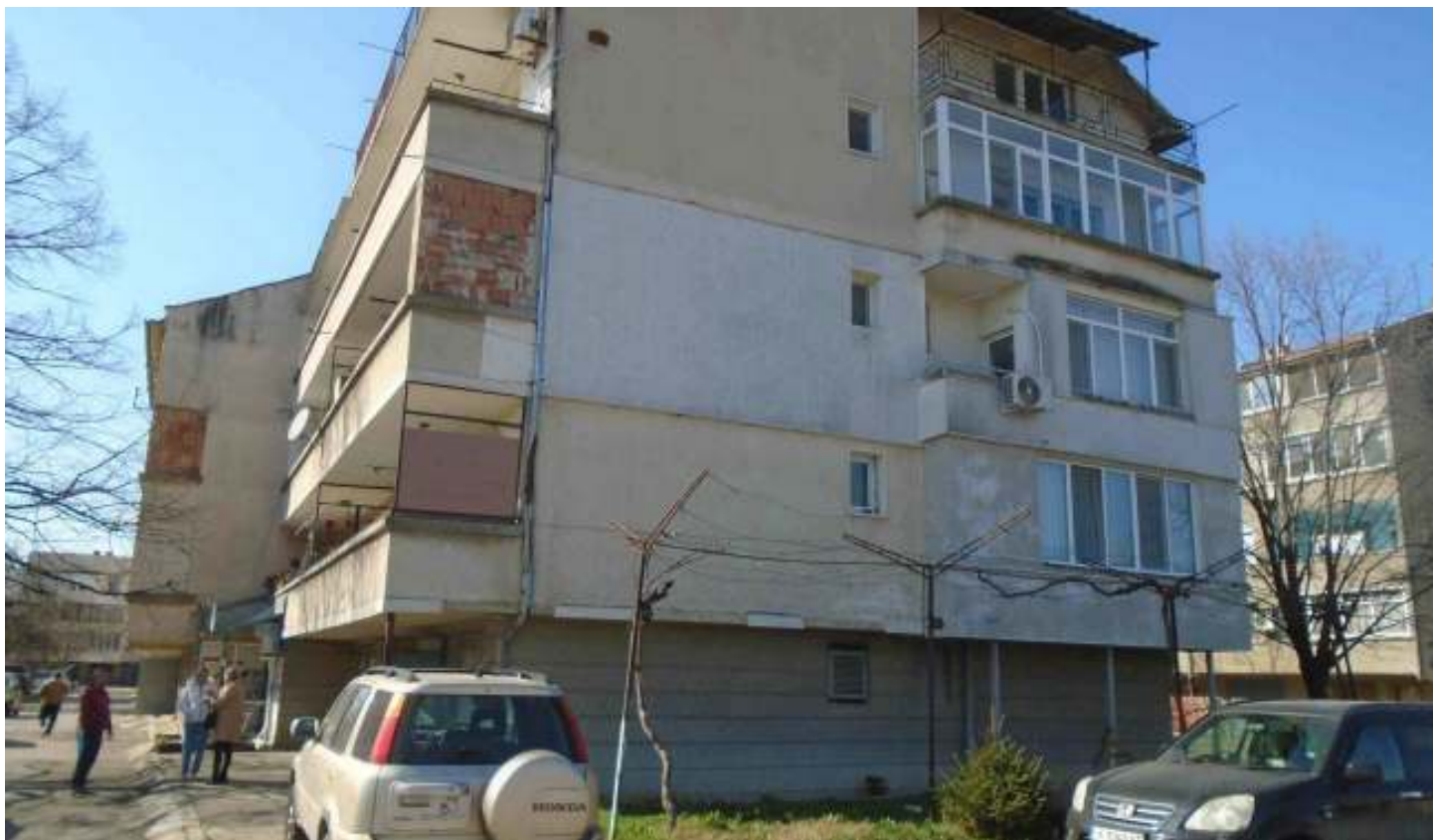
кв. Възраждане бл.43 - изглед от изток
